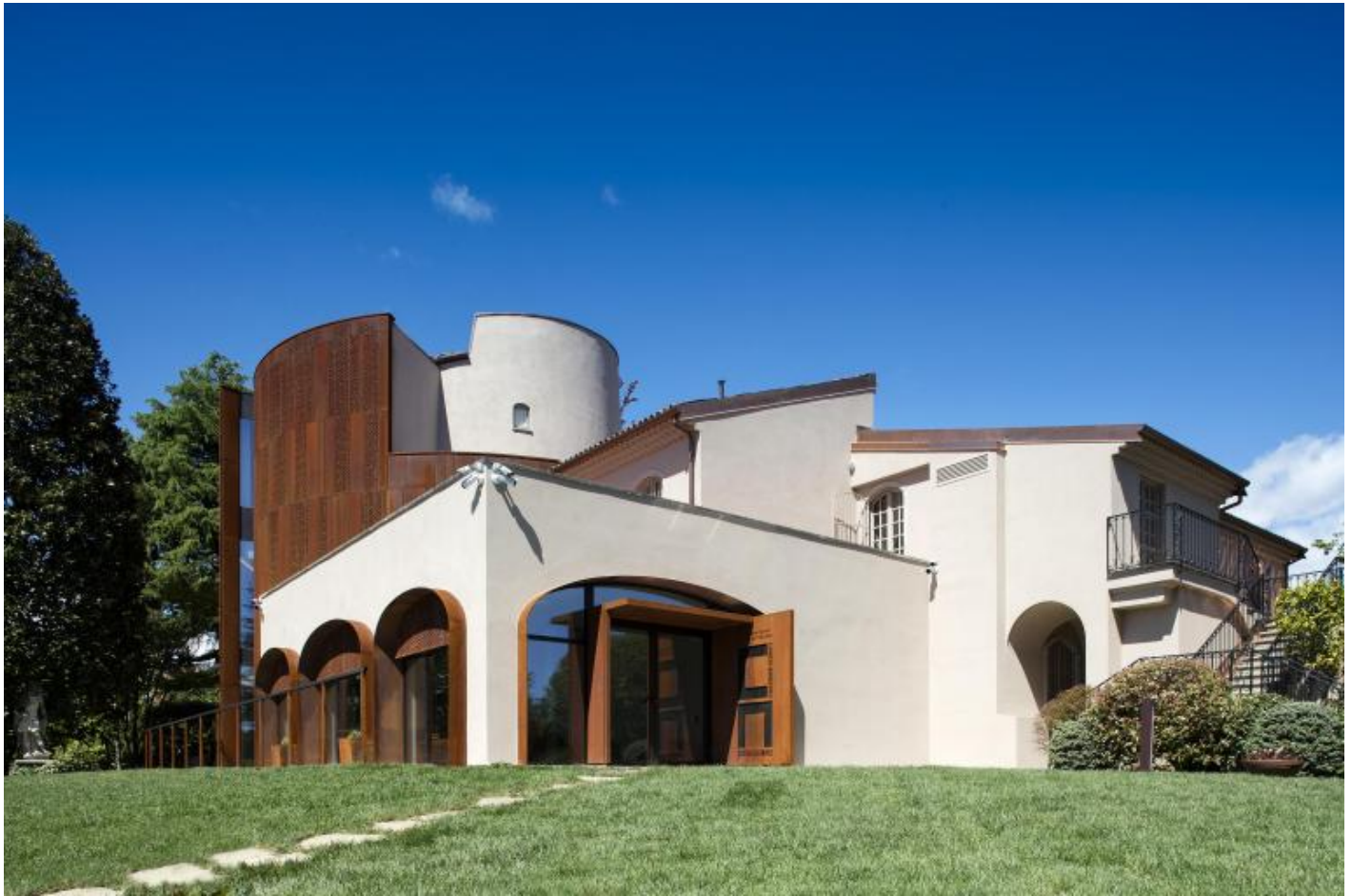
Villa Cerruti esterni.
