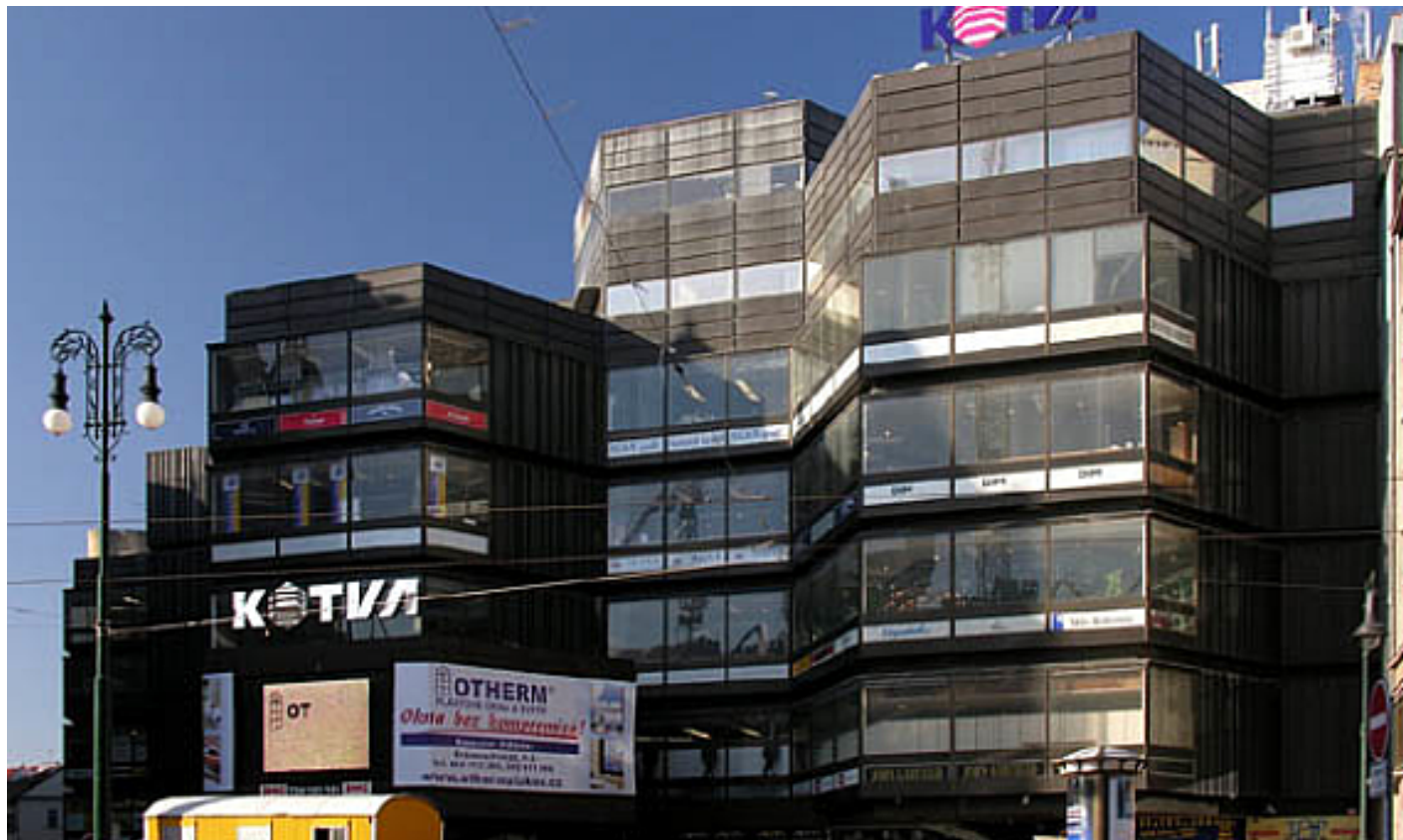
Il complesso dei grandi magazzini Kotva.
