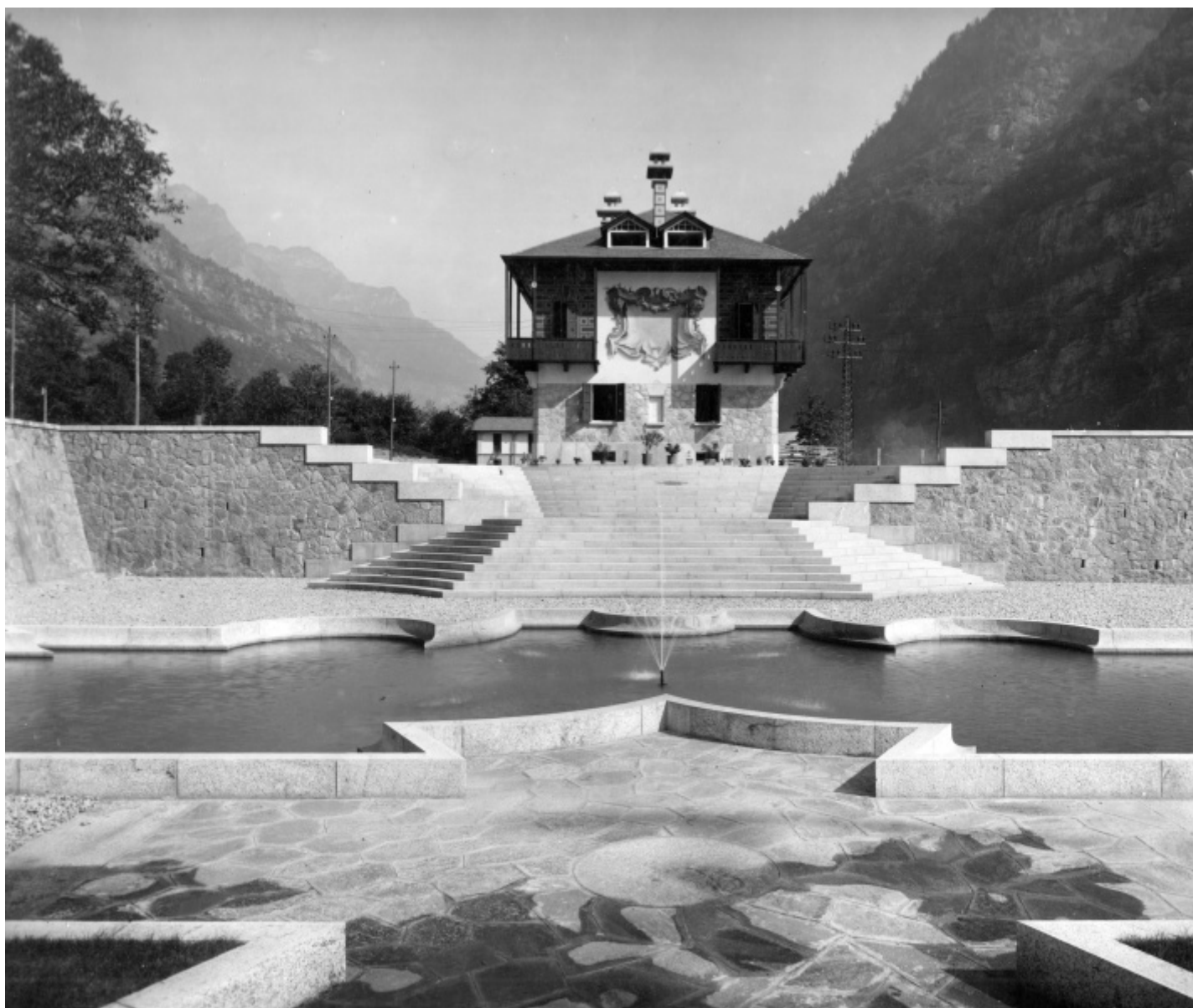
Centrale di Cadarese, foto Antonio Paoletti.
